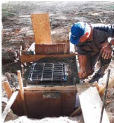
- Captage des eaux de ruissellement avec conduite pour alimenter l'étang communal.
