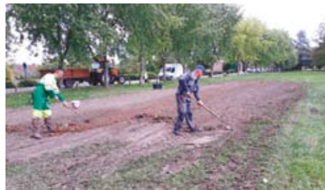
- Nivelage du terrain autour de l'étang et mise en pelouse par les employés communaux.
