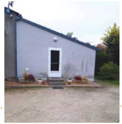
- Remise en état de l'entrée arrière du foyer (côté bar) avec
