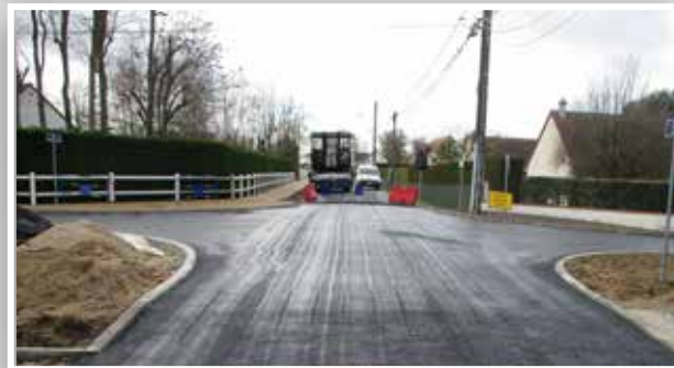
Travaux rue des Acacias
